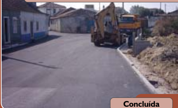
Beneficiação de Arruamentos em Cardais
