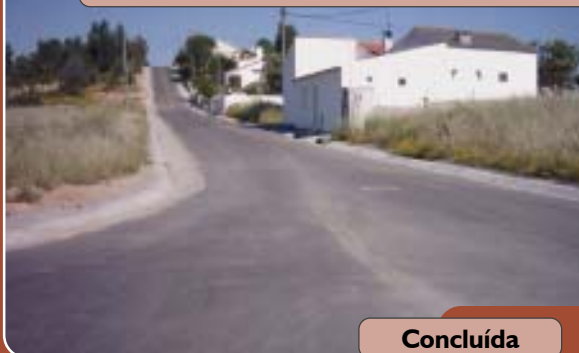
Beneficiação da Rua do Alto dos Sobreiros Meia Via
