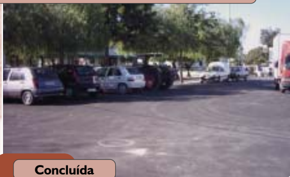
Reforço da pavimentação no Bairro do Nicho - Riachos
