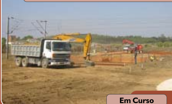
Viaduto Sul em Riachos
