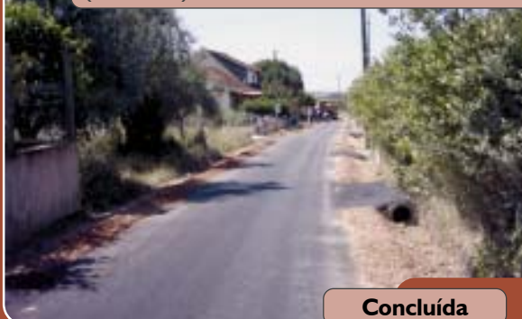
Pavimentação do Caminho Agrícola do Campo (Vale Cano)
